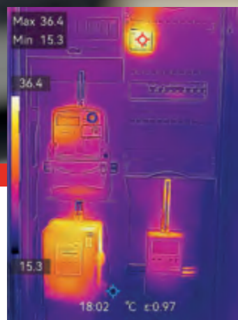
Wärmebild einer Hausverteilung mit Stromzählern und Sicherungsautomaten. Die Erwärmung des Steuerrelais (oberer Bildbereich) ist noch im Normalbereich
